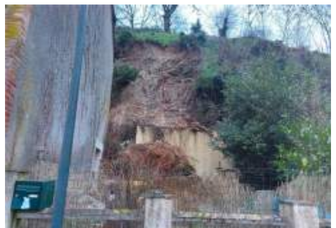
Glissement de terrain - Montreuil-sur-Maine @BRGM, 2025
